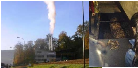
Stockmar : visite thermoréseau
